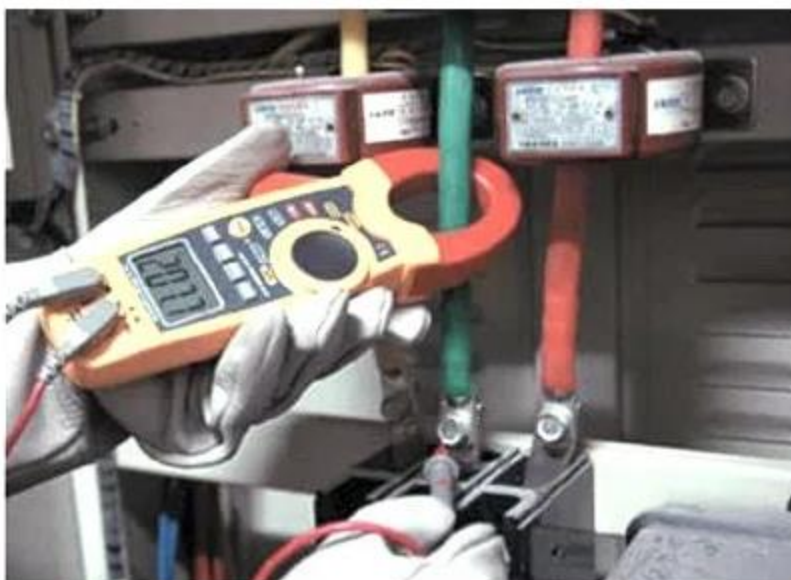
Рисунок 12 – Включение токоизмерительных клещей
